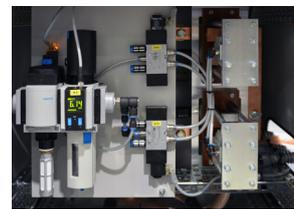
Stromschalter mit Pneumatikeinheit
